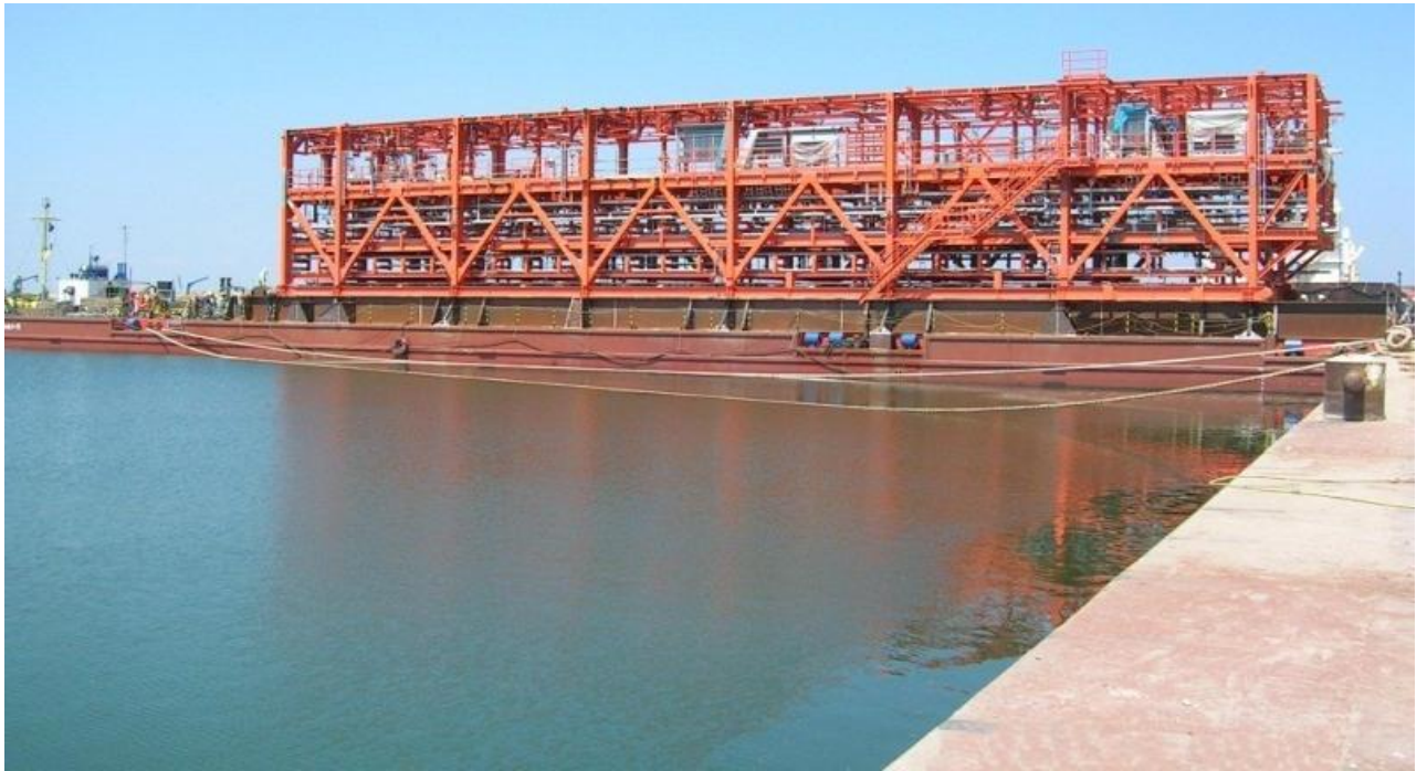
Мал. 14. Навантаження технологічного модуля на плавучий понтон ТМІ-5 в порту Равенна (Італія) методом накату.
